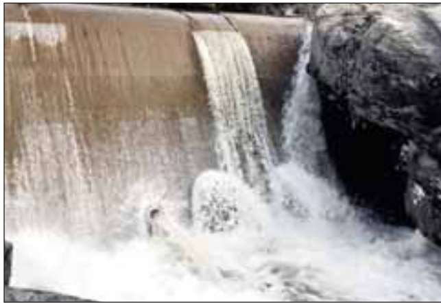
KRAFTSYMFONI. Tapping nederst i dammen sikrer minstevannføring på 120 liter i sekundet.
