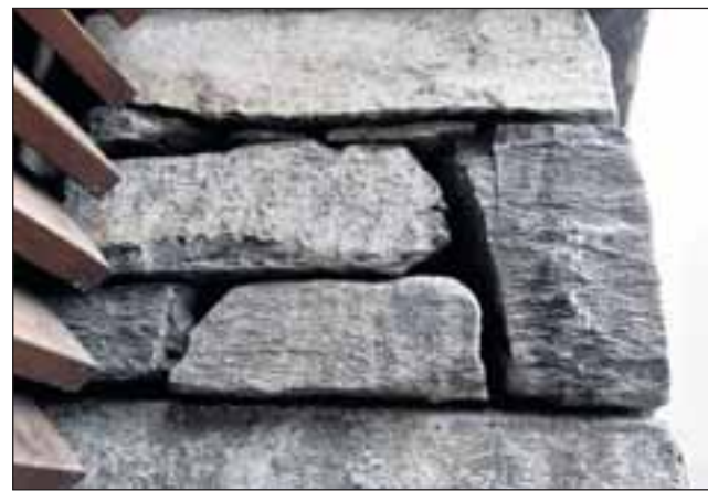
ARKITEKT MED SANS for lokal byggeskikk og tradisjonelt materialvalg.
