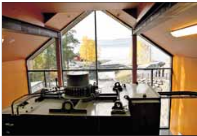
KRAFTIG UTSYN fra «toppetasjen». Toppen av turbinen og naturen utenfor som dras inn.
