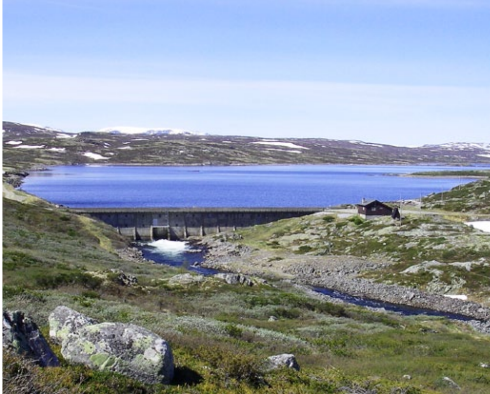
Dam i utløpet av Mjåvatn.
